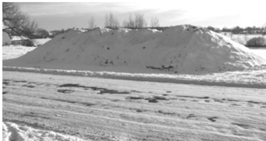
Prawidłowo zabezpieczona przez mrozami pryzma
